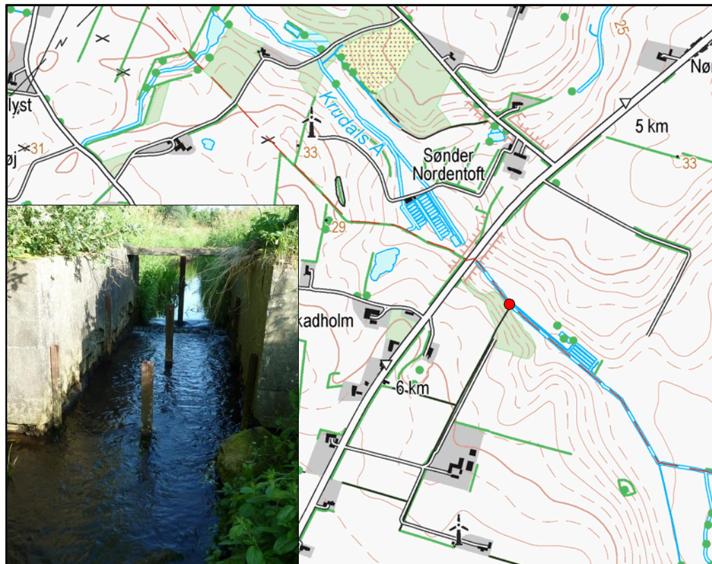
Figur 1: Spærring AAL-1275, opstemning ved nedlagt dambrug med vandspejlsfald på ca. 15 cm.
